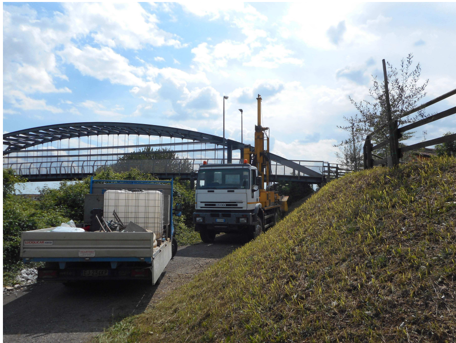
Sondaggio S1: posizionamento delle attrezzature.
